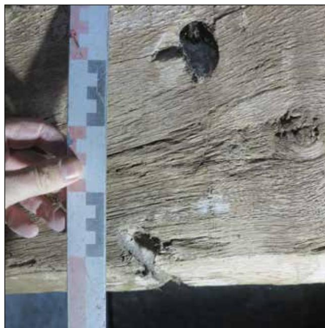
**Fig. 31** : Perforations obliques (trous de flottage) sur l'entrait de la ferme FP 06 (Cliché : C. Alix, PAVO).
