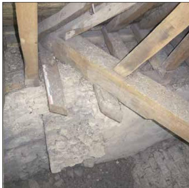
**Fig. 43 :** Chœur, coyer sud posé sur des sablières sciées, surplombant l'arrachement d'un mur, correspondant au chevet plat de l'abside provisoire (Cliché : C. Alix, PAVO).
