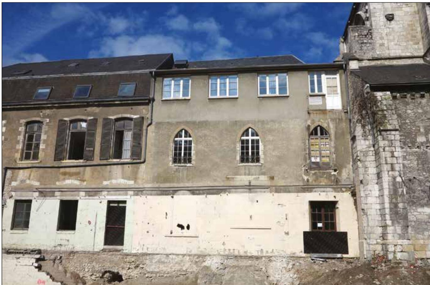
**Fig. 10** : Vue d'ensemble de l'aile orientale du cloître, depuis l'est. Les baies murées en arc brisé dans la moitié nord suggèrent une préservation des maçonneries médiévales (Cliché : C. Alix, Pôle d'archéologie).
