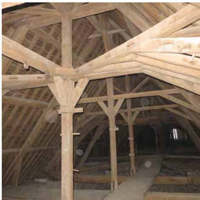
**Fig. 42 :** Chœur, vue vers l'ouest de la ferme FC 03, avec mortaises orphelines sur les coyers et l'arêtier nord, correspondant à l'ancienne croupe de l'abside provisoire (Cliché : C. Alix, PAVO).
