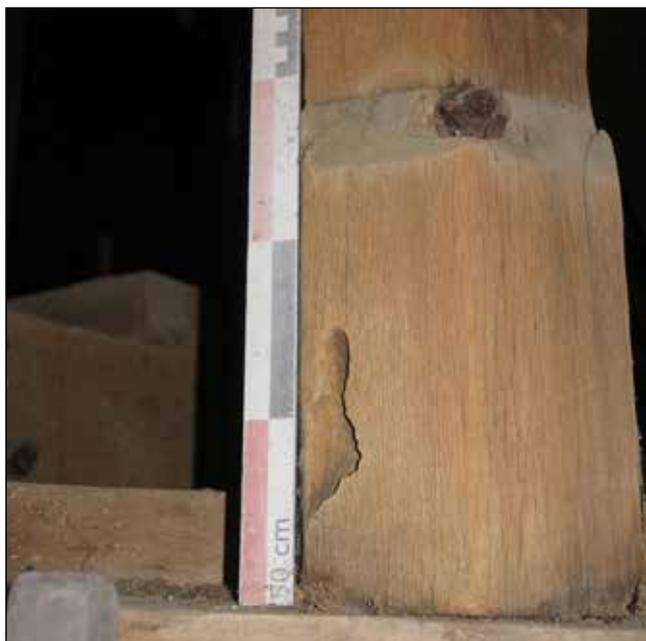
**Fig. 37** : Détail du pied d'un poteau pentagonal de l'armature de l'ancien clocher à la croisée du transept. Renfort métallique des années 1960 (Cliché : C. Alix, PAVO).
