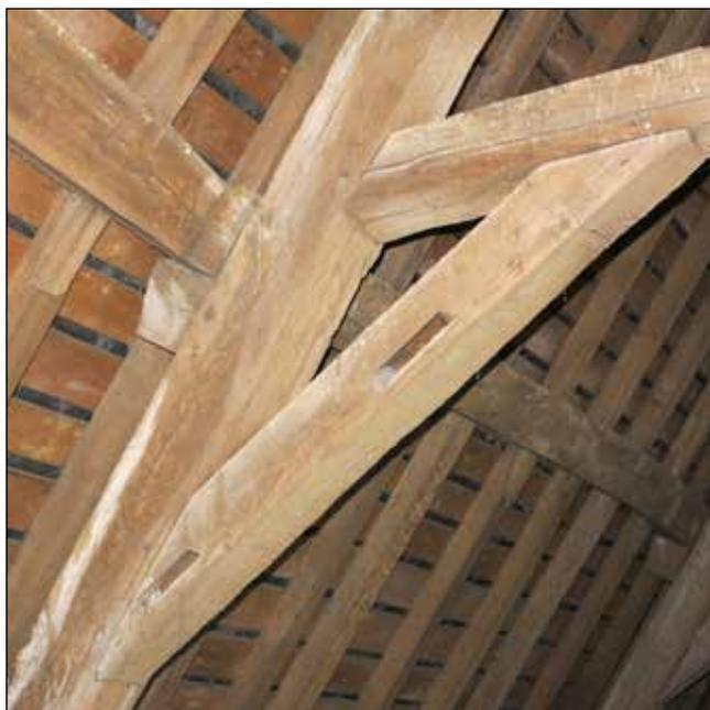
**Fig. 26** : Exemple de bois en remploi (deux mortaises orphelines), aisselier de la ferme FP 05 (Cliché : C. Alix, PAVO).
