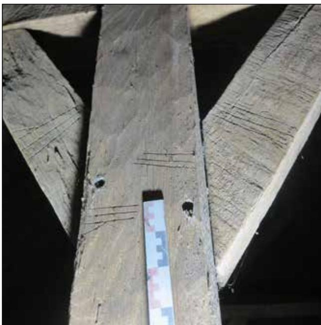
**Fig. 29** : Marques d'assemblages gravées n° 3 (III) avec crochets et demi-ronds, traces de scie et de hache, sur la ferme FTS 01 (Cliché : C. Alix, PAVO).
