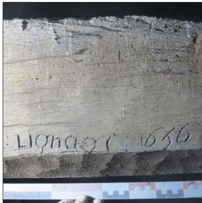
**Fig. 30** : Graffiti gravés, avec millésime « 1656 », recoupés par la retaille du flèche sur l'arête sur l'entrait de la ferme FC 04 (Cliché : C. Alix, PAVO).
