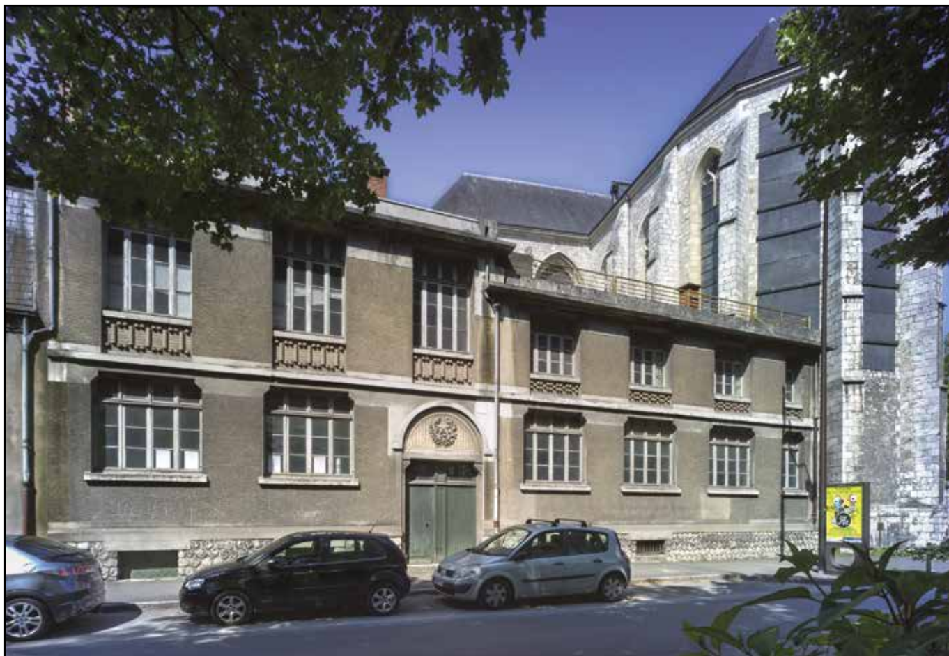
Fig. 20 : Vue depuis le Boulevard Saint-Euverte du bâtiment de front de rue, datant des années 1920 ou 1930. On peut observer les soupiraux indiquant la présence des sous-sols semi-excavés au fond desquels sont conservés les vestiges antiques et médiévaux (Issu du dossier IA45002714 de l'Inventaire, https://patrimoine.regioncentre.fr/gertrude-diffusion/illustration/ivr-2420144500275nuc4a/dc0a684e-d8f5-4e62-918f-5260ad5a22dd ).
