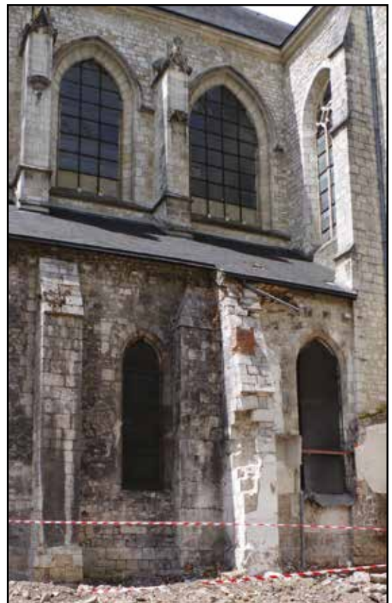
Fig. 25 : Contreforts du collateral est du transept sud de l'église Saint-Euverte, détériorés lors de la démolition des bâtiments adjacents (Cliché : J. Courtois, Pôle d'archéologie).
