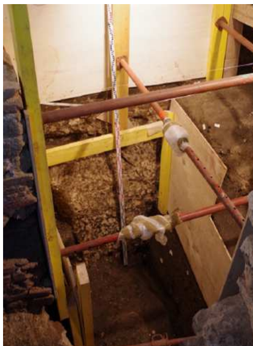
Figure 7 : fouille archéologique à parois butonnées
