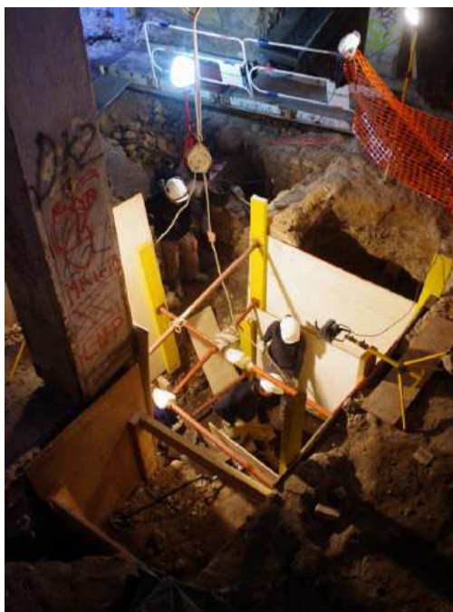
Figure 7 : fouille archéologique à parois butonnées
