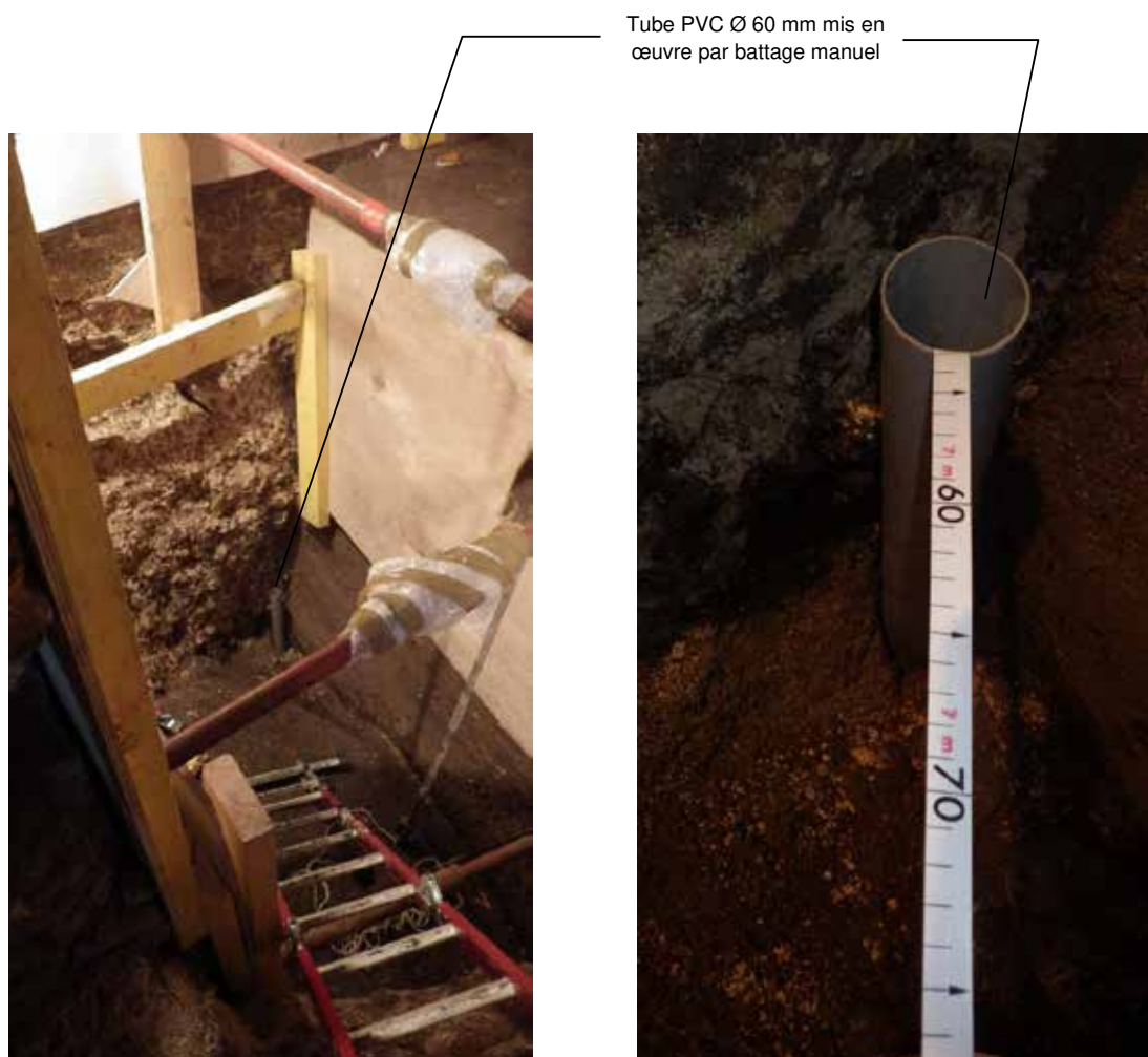
Figure 10 : battage d'un tube jusqu'au toit du vide franc
