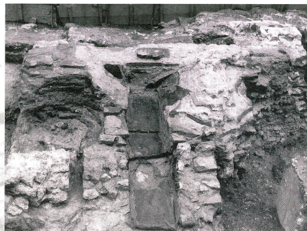
Ilot Nazareth. Second entrepôt sud, détail, vue du sud. Système d'évacuation d'eau. La partie inférieure est construite en pierres calcaires et mortier jaune, la partie supérieure en briques et mortier de tuileau. De profil évasé, le collecteur situé à l'arrière-plan ouvre sur un conduit plus étroit, en légère déclivité vers le sud. Les parois du collecteur et le fond du conduit sont recouverts de briques plates. L'ensemble de ce dispositif facilite le bon écoulement de l'eau.
