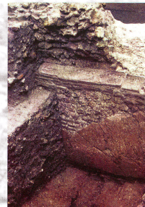
Ilot Nazareth. Entrepôt sud-ouest, sous-sol, détail, vue de l'ouest. Le bâtiment s'implante en partie sur la destruction du petit entrepôt. Les murs, construits en pierres calcaires et briques alternées, supportent une voûte constituée d'un arc en briques surmonté d'une maçonnerie en pierres calcaires noyées dans du mortier. Le sol et les enduits muraux sont en mortier de tuileau afin, sans doute, de protéger la salle de l'humidité. Ce bâtiment dont la construction n'est pas datée, est détruit et comblé à la fin du IV e ou au début du V e siècle de notre ère.
