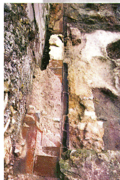
Ilot Nazareth. Entrepôts sud, détail, vue du nord. A droite mur d'un premier bâtiment construit en pierres calcaires et mortier jaune ; à gauche mur d'un second bâtiment construit, sur la démolition du précédent, en pierres calcaires et briques alternées liées au mortier rose.
