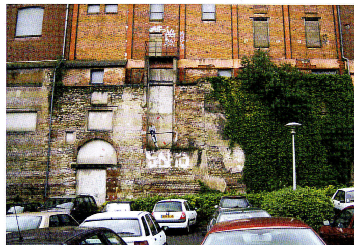
Fig. 11 : vue générale du rempart (17 rue de la Tour-Neuve) L'entrepôt en brique qui prend appui sur le mur antique correspond à un des bâtiments des usines Dessaux (19 e et 20 e siècle).
