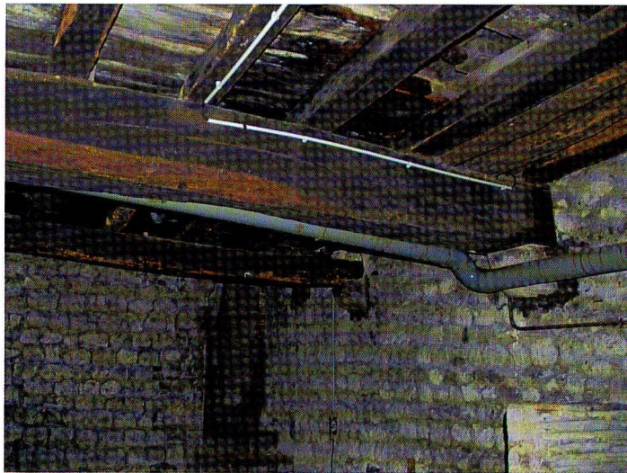
Fig. 6 : 85 rue de la Charpenterie, plafond de la salle basse excavée (angle sud-ouest, corbeaux en pierre et poutres en bois)
