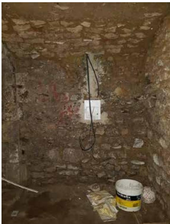
*Illustration 20 : Maçonnerie du mur à l'aide de moellons liés par un mortier, cave du 9 cloître Saint-Aignan (n°5), 12/04/2017.*
