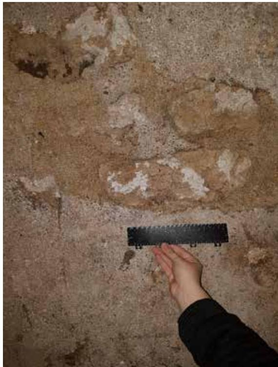
*Effritement localisé de la maçonnerie du plafond du second étage de la cave (I2.2)*
