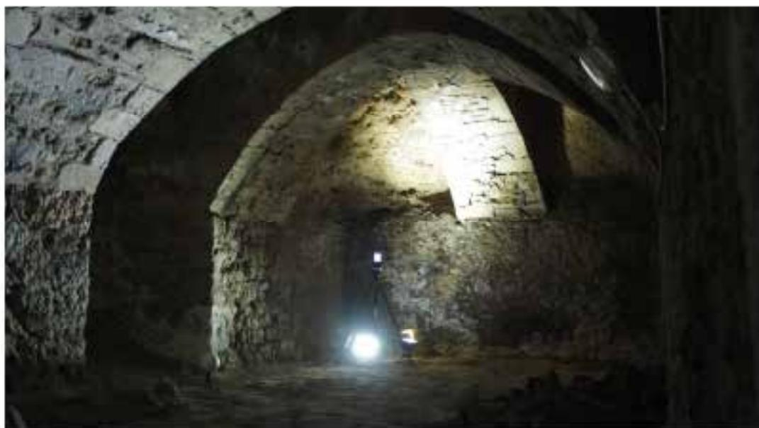
Photographie 1 : Cavité visitée le 7 avril 2017. Cette cavité constituait une ancienne carrière de calcaire de Beauce. Elle est étagée sur 3 niveaux. Cette cavité a été passée au scanner 3D. Il s'agit d'une méthode d'analyse très récente qui vise à reconstruire la cavité en 3 dimensions de sorte à récupérer le plus d'informations possibles (espace, galerie, voûte, soutènement, trave, arches, etc.) sans avoir besoin de visiter la cavité à nouveau.
