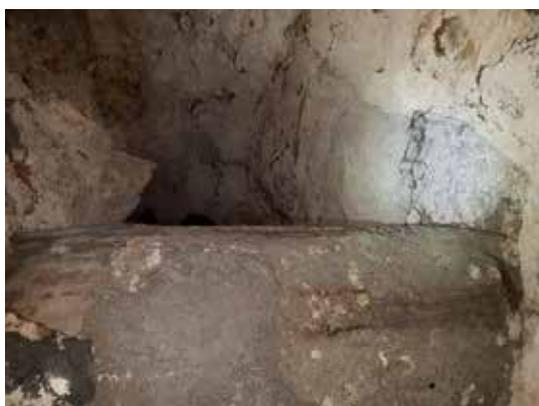
Illustration 35 : Remontée de cloche de foyers à côté d'un puitsard de la carrière du 20 Place Croix-Morin (n°9), 05/07/2017.
