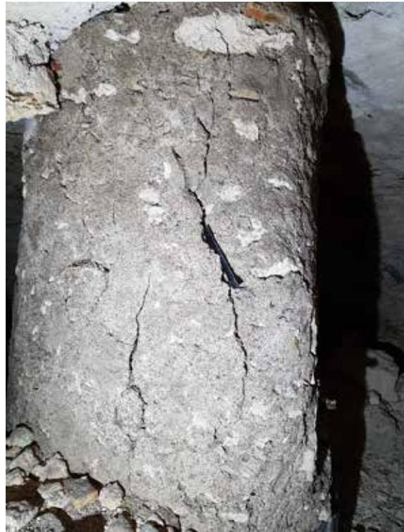
*Illustration 46 : Exemple de fissure au niveau de la maçonnerie d'un puits dans la carrière du 20 Place Croix-Morin (n°9), 05/07/2017.*
