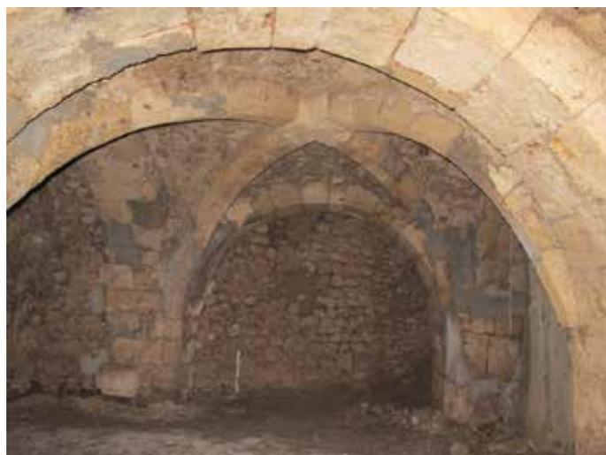
Fig. 7 : Confortement d'une cavité par re-jointoiement des piliers et arcs médiévaux, au 52 rue Sainte-Euverte, SICAVOR 56 (Cl. : C. Alix, Pôle d'Archéologie de la ville d'Orléans).
