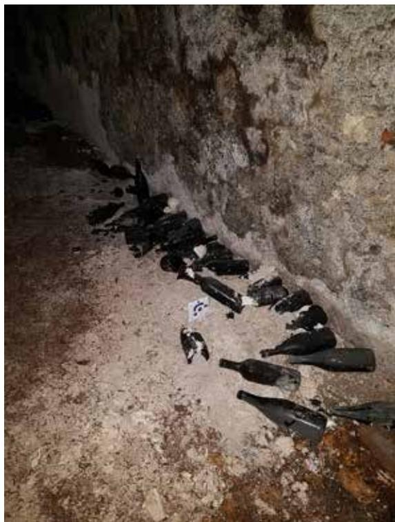
Illustration 32 : Effritement du calcaire de la paroi de la carrière, 55 rue de la Bretonnerie (n°1), 03/04/2017.
