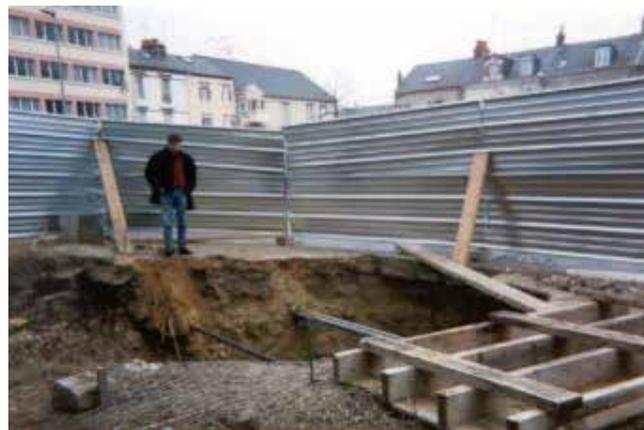
Fig. 5 : Désordres en surface liés à des effondrements de cavités souterraines à Orléans. Au-dessus, a : Fontis (diamètre 6 m, profondeur 11 m) ; en-dessous, b : Effondrement d'une maison Faubourg Banner. (Cl. : DEPR, Orléans Métropole).
