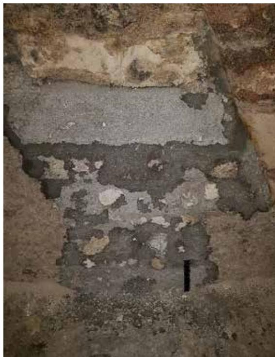
*Illustration 50 : Exemple de maçonnerie récente, reprenant une maçonnerie ancienne, observé dans la carrière du 11 rue de Tabour (n°3), 06/04/2017.*
