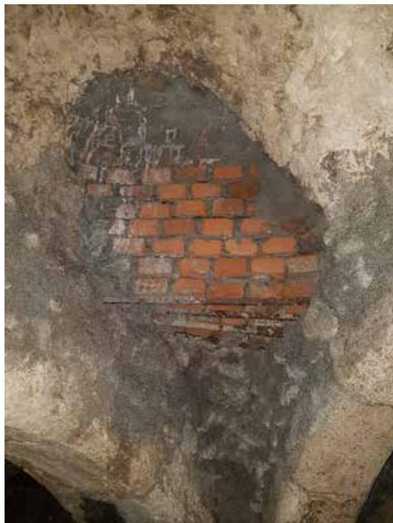
*Illustration 51 : Confortement du ciel avec des briques et des tiges de fer, observé dans la carrière du 11 rue du Tabour (n°3), 06/04/2017.*
