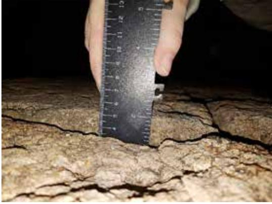
*Altération du mortier servant à lier plusieurs blocs entre eux, servant de soutènement dans la carrière (I3.1)*
