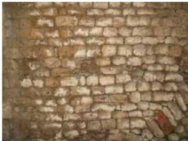
**Joints moins marqués et quelques moellons manquants – Mur Sud côté Est**
