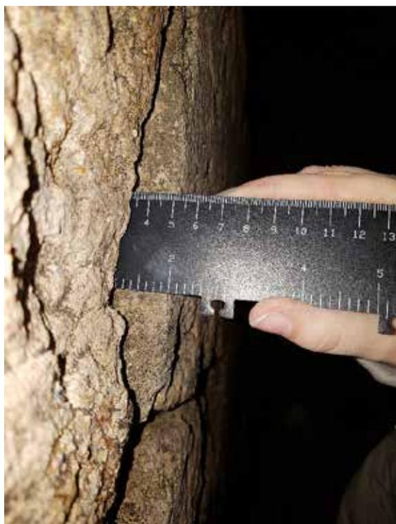
*Illustration 43 : Altération du mortier entre deux blocs de pierre dans la carrière du 21 rue Saint-Etienne (n°4), 07/04/2017.*
