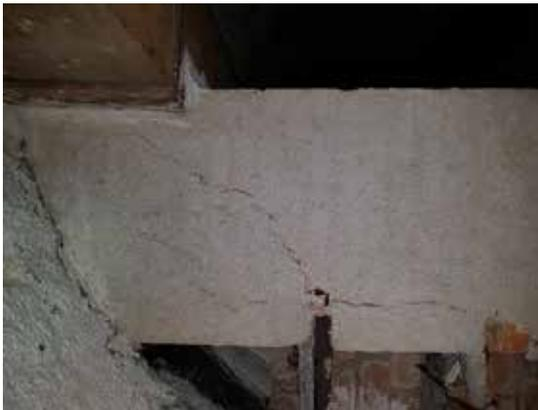
Fissure le long d'un pilier maçonné de la cave (I1.1)
